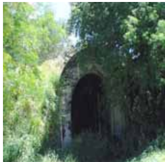
厚いコンクリート製の海軍弾薬庫跡
